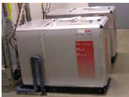
Figura 35: Sistema de micro cogeneración Stirling. 2. Fuente: Solo's
