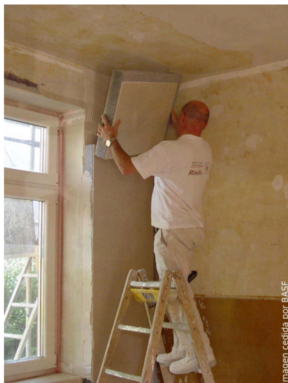
Figura 11: Aislamiento alrededor del hueco de ventana
