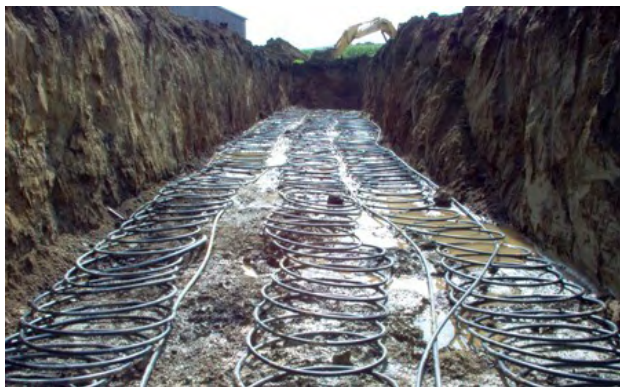
Figura 37: Geotérmica. Distribución de colectores en el terreno
